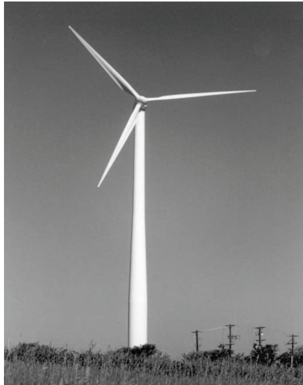
Figura 2.2 Turbina de viento de eje horizontal con 3 aspas.
