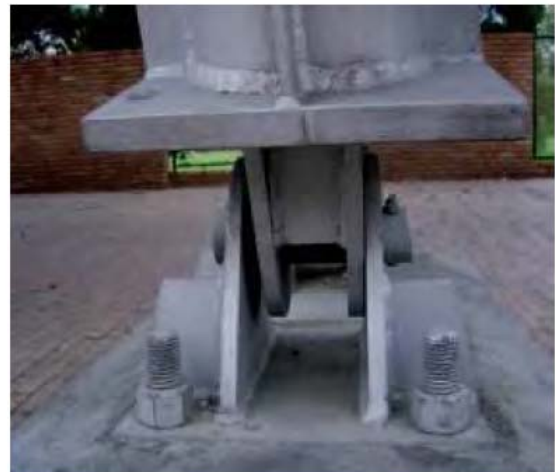
Fig. 2.22 Configuración de elemento para soportar los esfuerzos cortantes.
