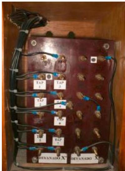
Figura 5.4 Configuración física del transformador defasador monofásico.
