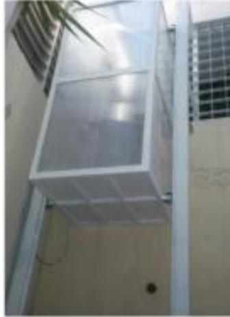
**Figura 4.1.- Sistema de elevación con cabina completa**
